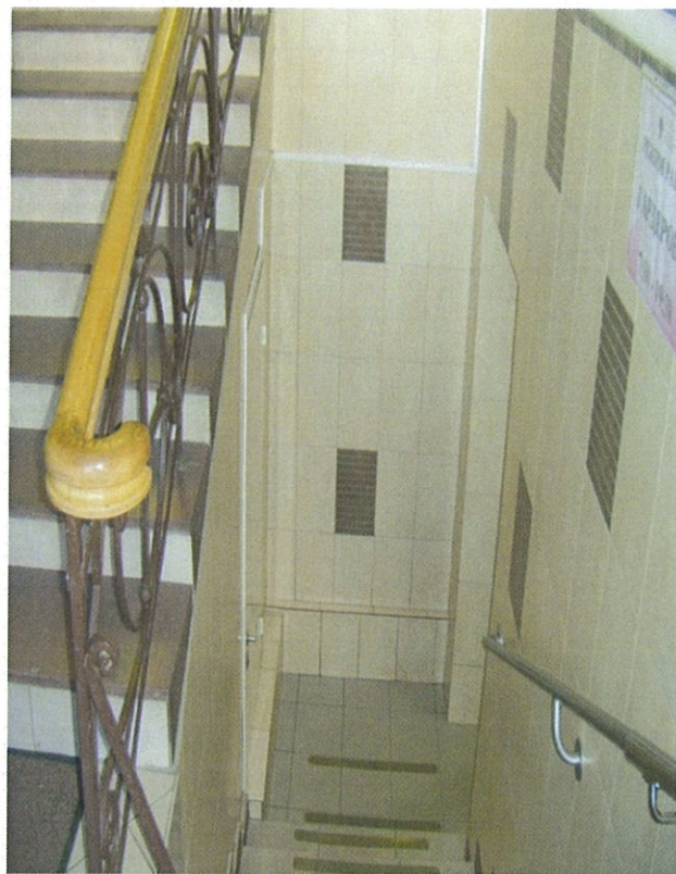
Фото 10. Лестница в гардероб
