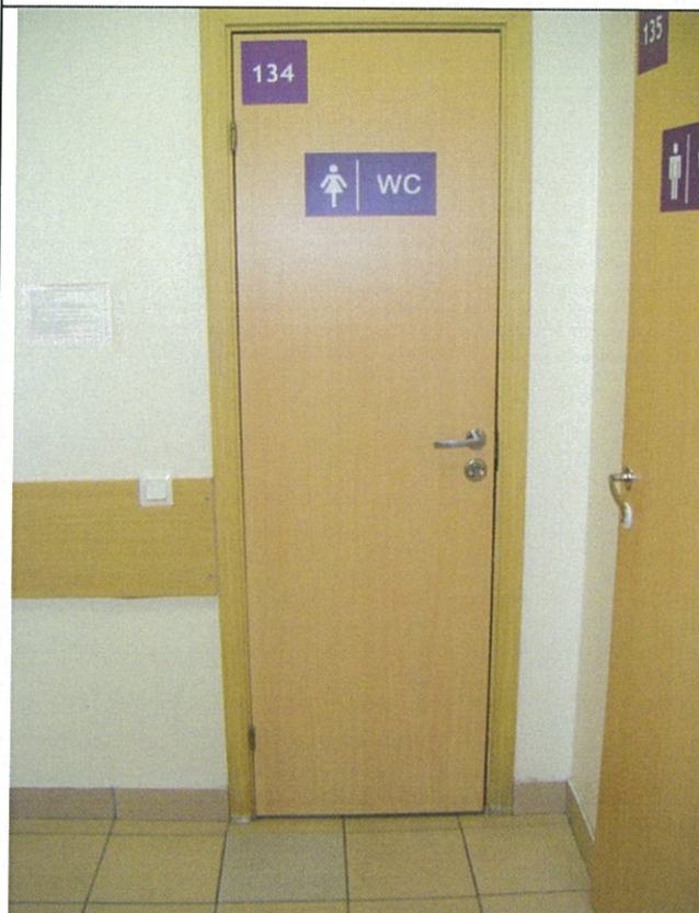
Фото 21. Общая уборная 1 этаж
